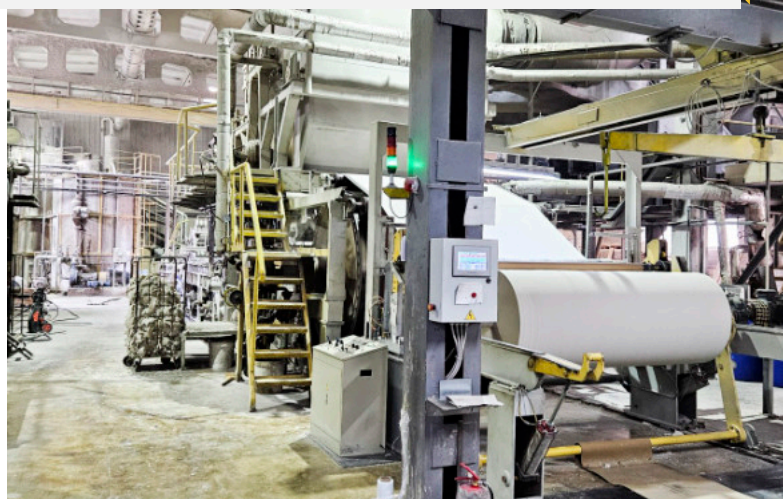
ORAZ PO ODBUDOWIE ZAKŁADU
