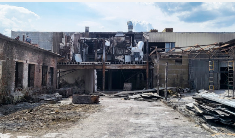
HALA PO ZNISZCZENIU
